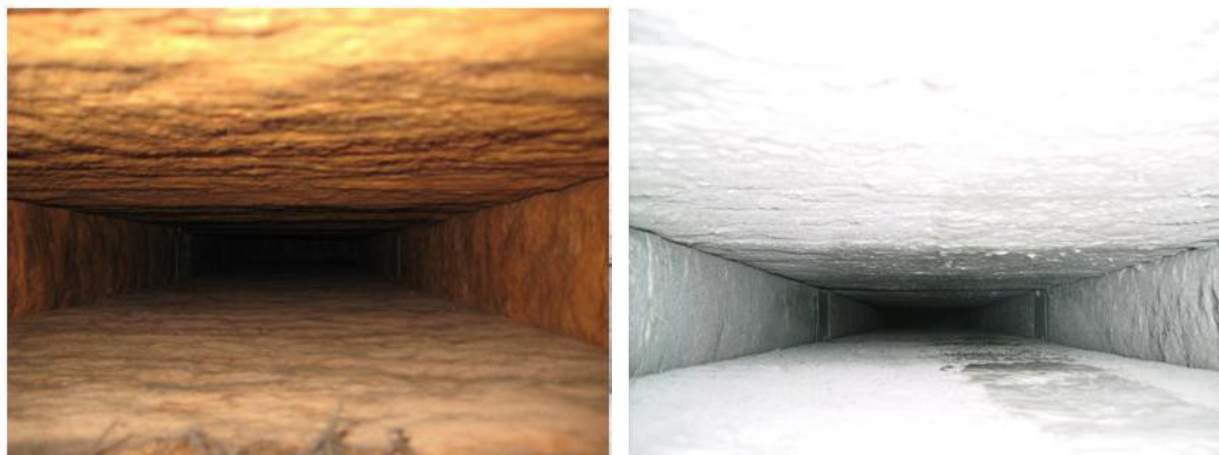
FOTO 1 e 2. Esempio di coating eseguito su una condotta con coibentazione interna.
